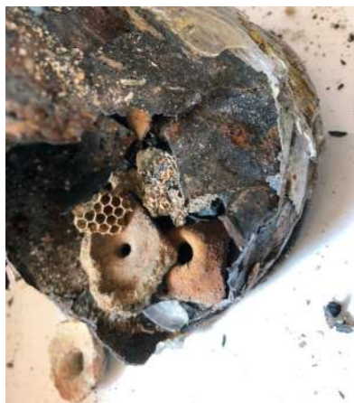
Ninhos de vespa que se preservaram apesar do calor e da queda do terceiro para o primeiro andar / Wasp nests that resisted preserved despite the heat and the fall from the third to the first floor.
