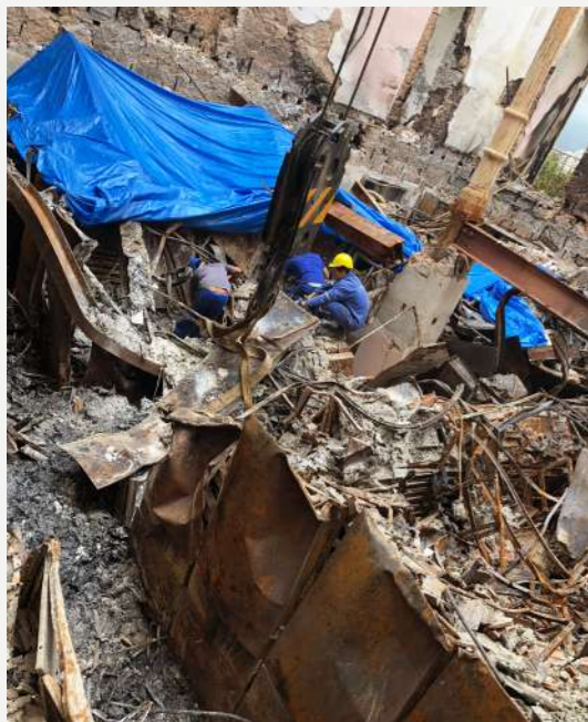
Área das coleções Paleontológicas após o incêndio / Area of the Paleontological collections after the fire.
