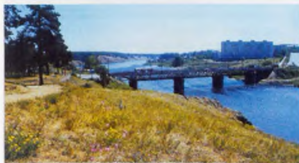
Мост через р.Исеть (Каменск-Уральский)
