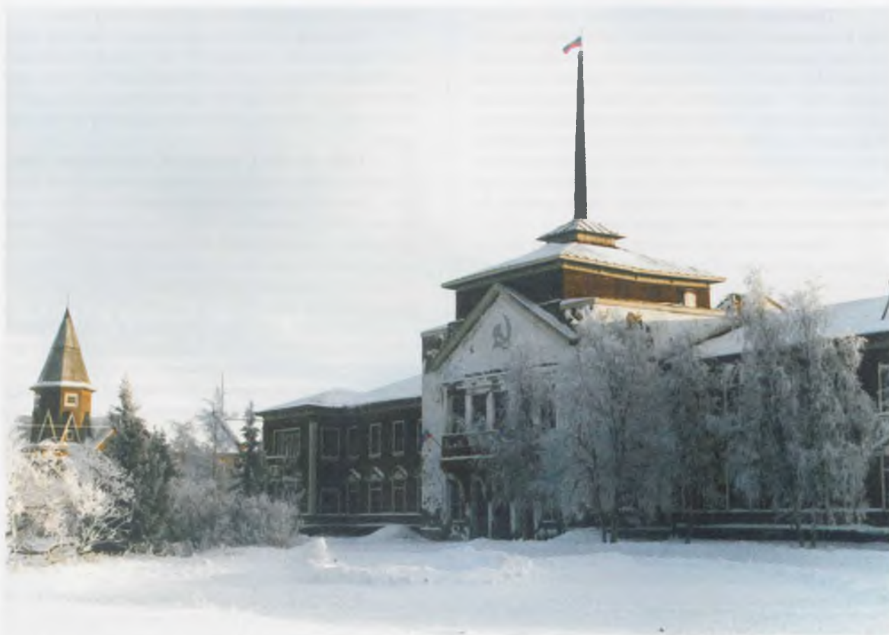
Здание Администрации округа
