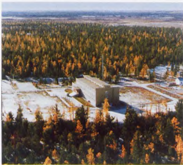
Профилактический центр «Надымгазпрома»
