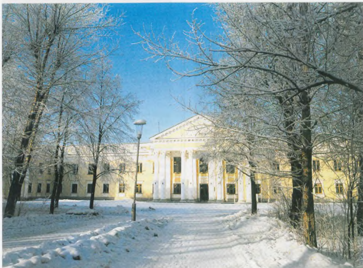
Административное здание Уральского электрохимического комбината
