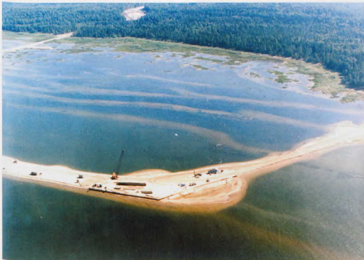
Строительство Усть-Лужского порта
