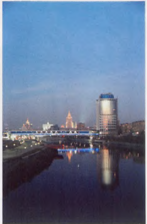
Строящийся комплекс «Москва-Сити»
