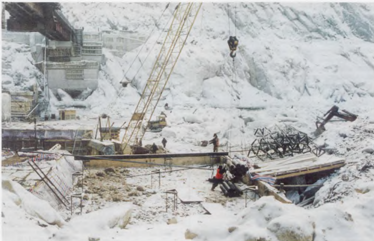
Строительство Бурейской ГЭС
