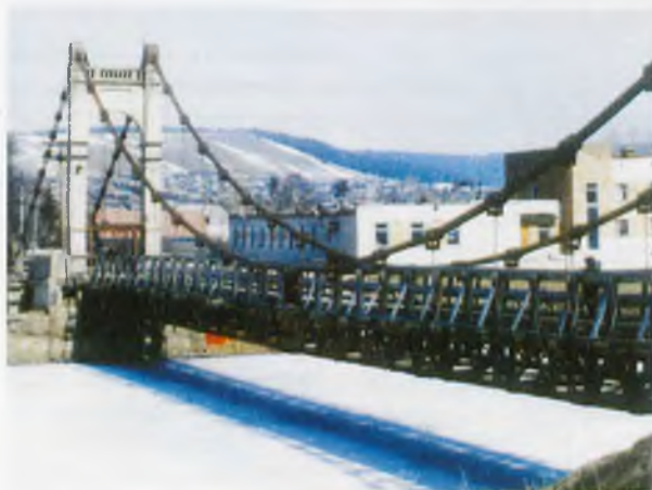
«Брянский» мост в Усть-Катаве
