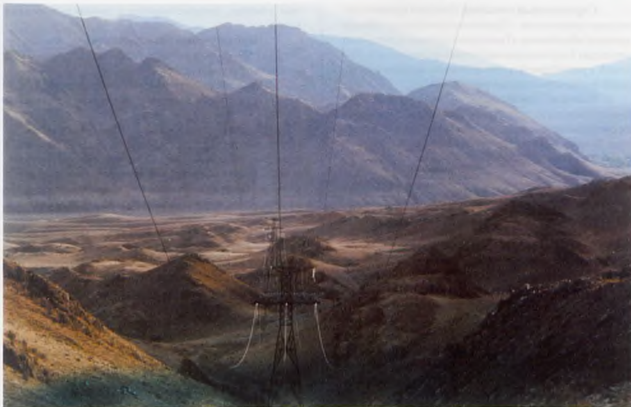
Линия электропередачи Абаза - Ак-Довурак
