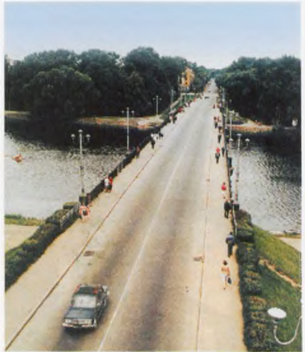
Мост через р. Ловать
