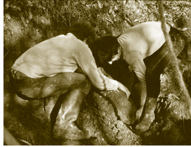
Vilma e Niède carregam pedra na reforma da "Boule Blanche", casa no Lot.
