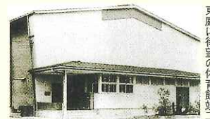
東庭に待望の体育館竣工
