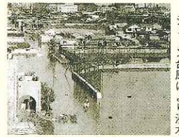
ジェーン台風により浸水
