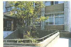
正面玄関の身障者用スロープ
